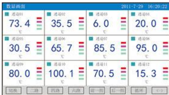
显示实时测量值、通道位号、工程单位及报警状态可
